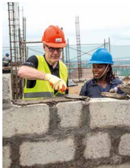
↑ Packt mit an: Arbeiterin Sharon setzt mit Rainer Brockhaus (l.) Mauersteine.
